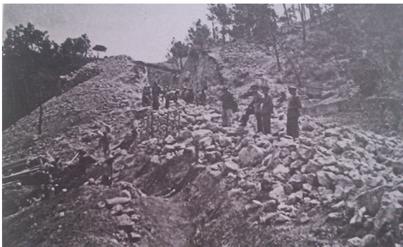
BDST 35, Son Morei, Mallorca, 1942. Fuente: AMAGV. M.E. C. 20904, Cp.2, F 10 I.H.C.M., M. de Defensa. Prisioneros trabajando en la construcción de la carretera
